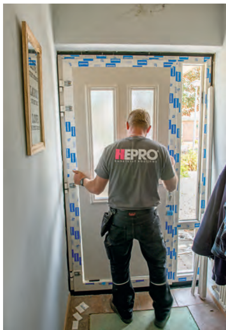
Montage van het deurpaneel
